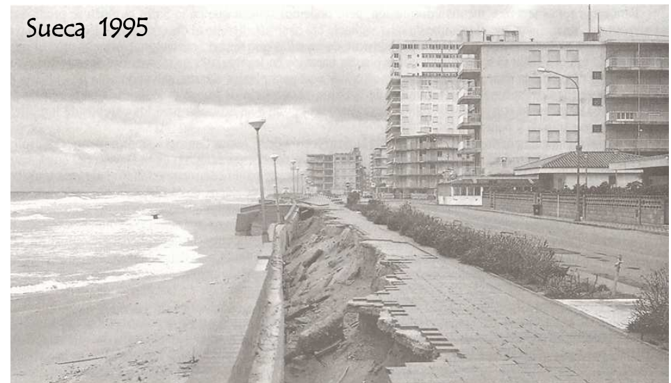
Sueca 1995 Paseo marítimo que forma una barrera artificial que no evita la erosión ni la invasión marina. La reserva de arena tapada en la construcción del paseo impide la regeneración de la playa después de un temporal.
